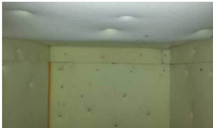
Fig. 7 – Placarea pereților interiori cu burete poliuretanic
