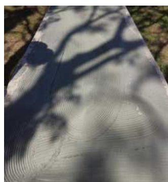
Fig. 2 – Fixare izolație pe placa de rigips
